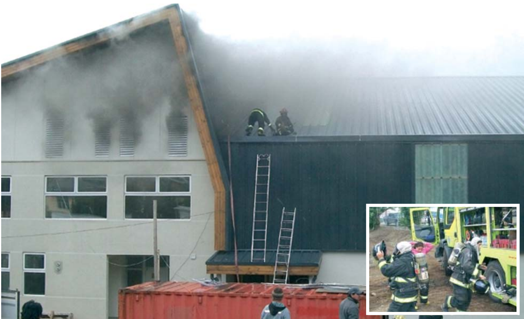
Incendio provocó daños en nuevas dependencias del liceo Juan Pablo II
